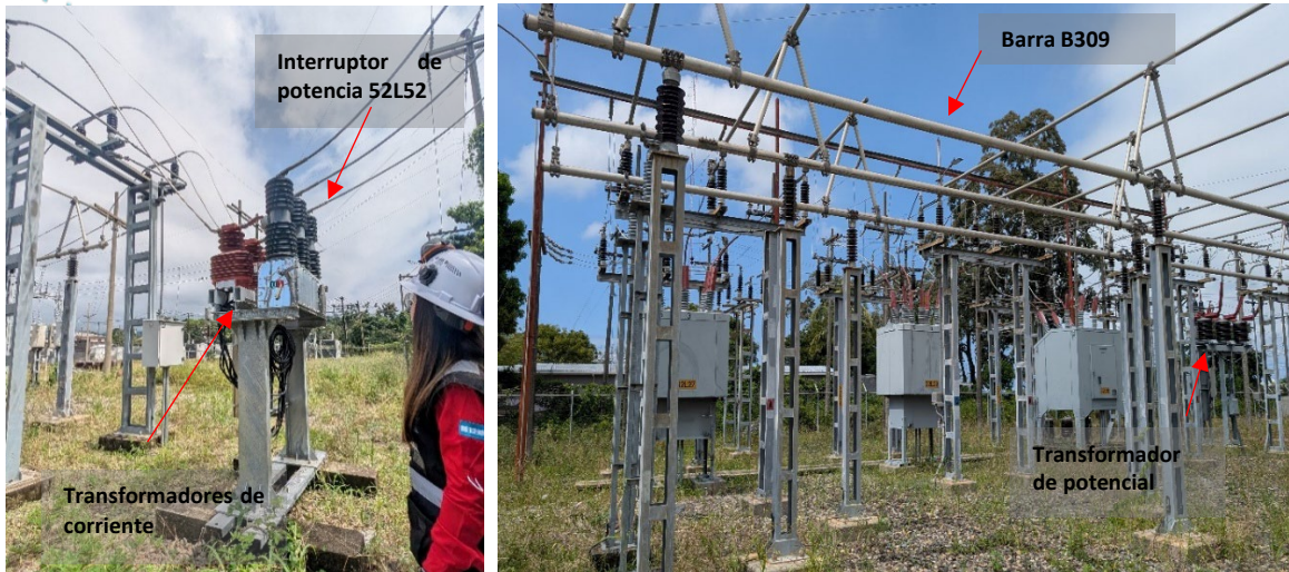
Imagen 3 Equipo de medición comercial de Arrendamiento Laeisz San Isidro (fuente: CREE)
