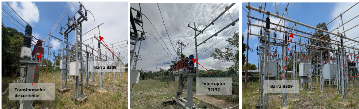
Imagen 5 Punto de conexión y medición, subestación San Isidro (fuente: CREE)
