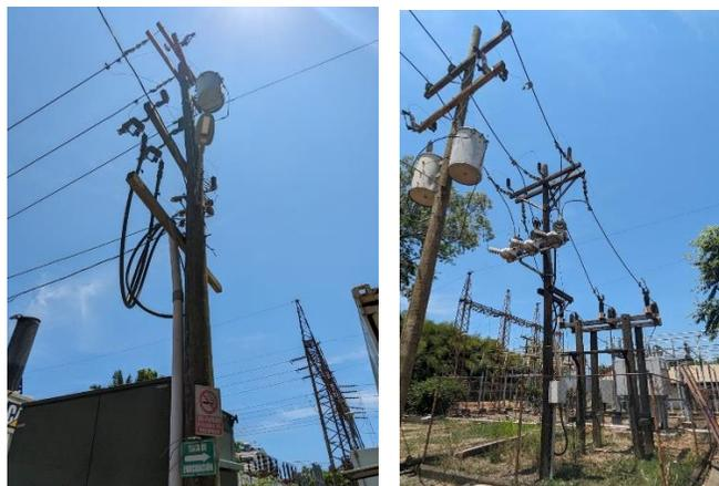
*Figura 2 (Dcha.) Elementos de protección de unidades de generación. (Izda.) Punto de conexión de la central LAT (fuente propia)*
