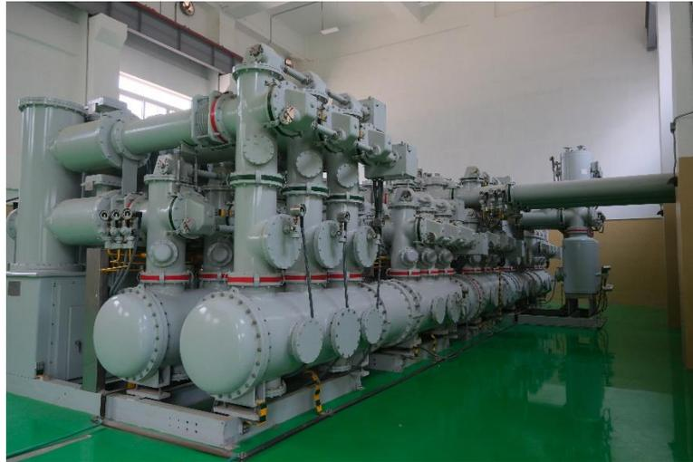
*Figura 17 Subestación eléctrica GIS (Gas Insulated Substation)*
