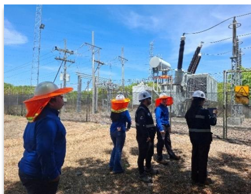
Imagen 16 Verificación del punto de conexión
