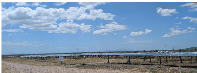
Imagen 22 Paneles solares de la central Solar Marcovia
