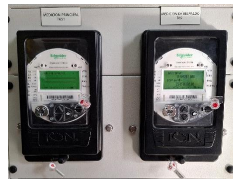
Imagen 15 Ubicación de la central y medidor principal y de respaldo
