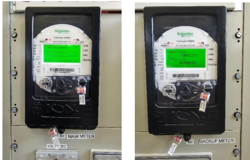
Imagen 20 Medidor principal y respaldo
