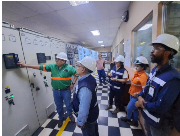
Figura 26 Inspección en la sala de control.
