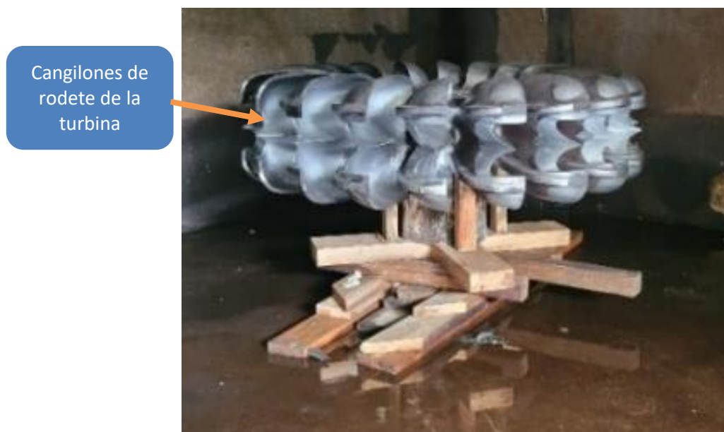
Figura 9 Reparación del rodete de la unidad 1.
