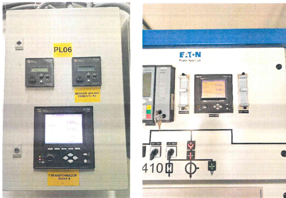
Imagen 20 Equipos de medición para comparación del consumo de la red y producción solar.
