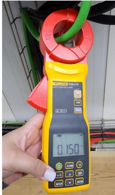
Imagen 7 Medición de puesta a tierra en inversor
