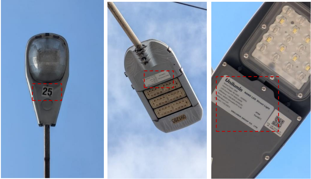
Imagen 52 Datos de placa y etiquetados de luminarias (fuente: CREE)
