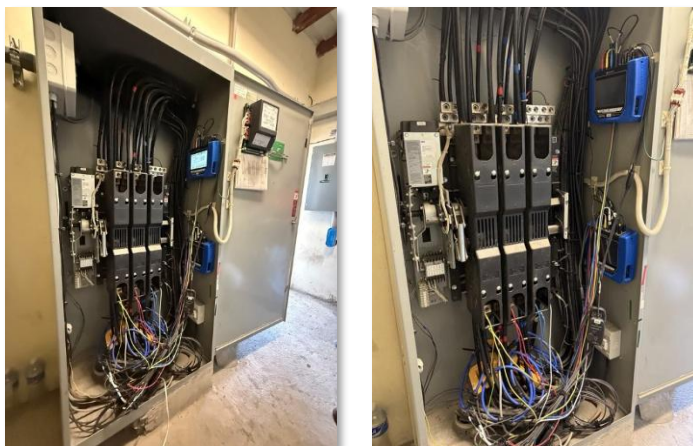
Imagen 5 Instalación de analizadores primera sesión (fuente: propia)
