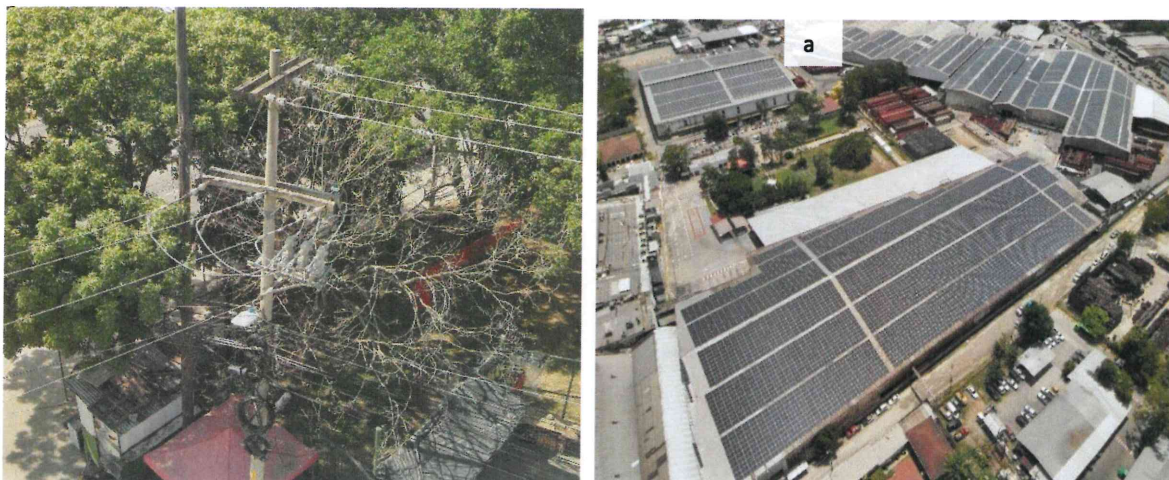
Imagen 12 a. Punto de suministro ENEE - Cervecería Hondureña SPS. || b. Instalación de paneles solares sobre las instalaciones de Cervecería Hondureña SPS
