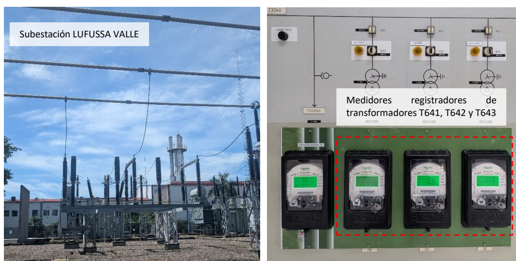
Imagen 5 Equipos de medición T641, T642 y T643
