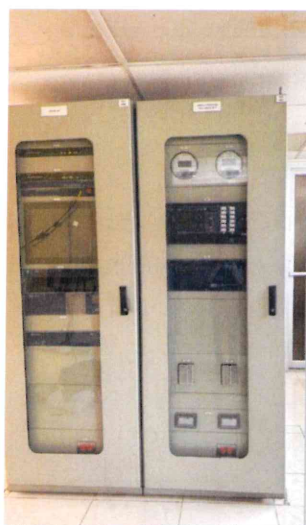
Imagen 54 Medición comercial principal y de respaldo
