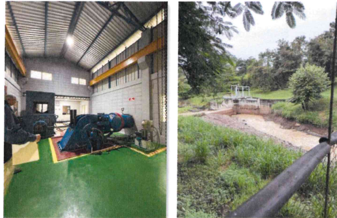
Imagen 47 Casa de máquinas y captación del agua (fuente: propia)
