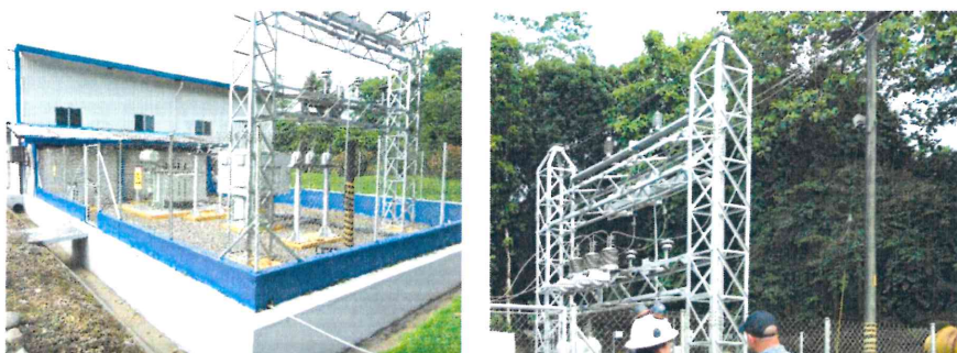
Imagen 3 Punto de Conexión y Medición y Transformadores de potencial -Circuito ENEE L352
