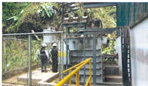
Imagen 8 Centro de transformación de la central
