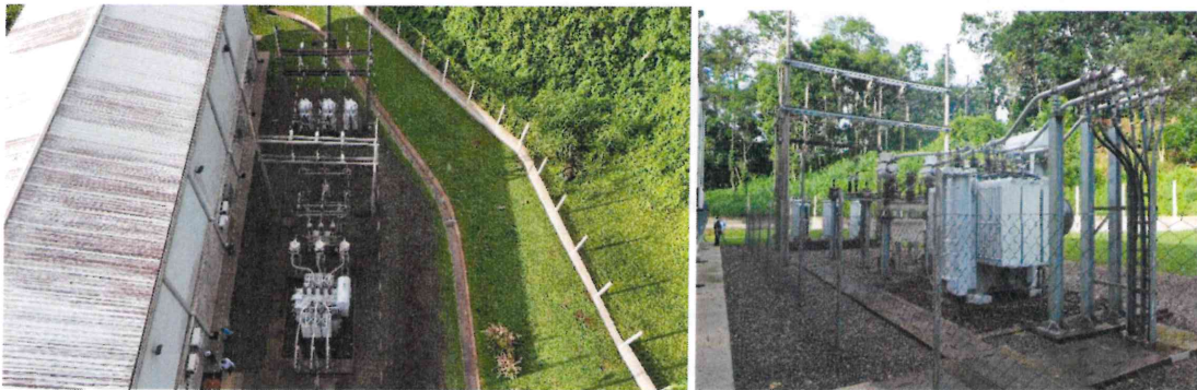
Imagen 29 Punto de Conexión y centro de transformación
