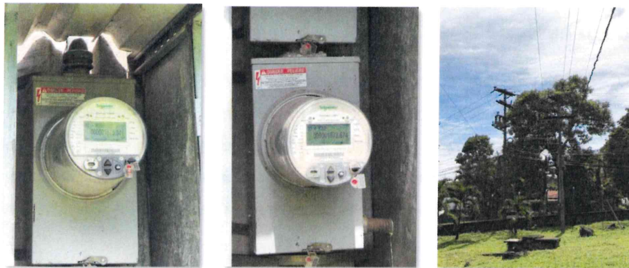
Imagen 43 Equipos de medición principal y de respaldo ubicados en la central generadora
