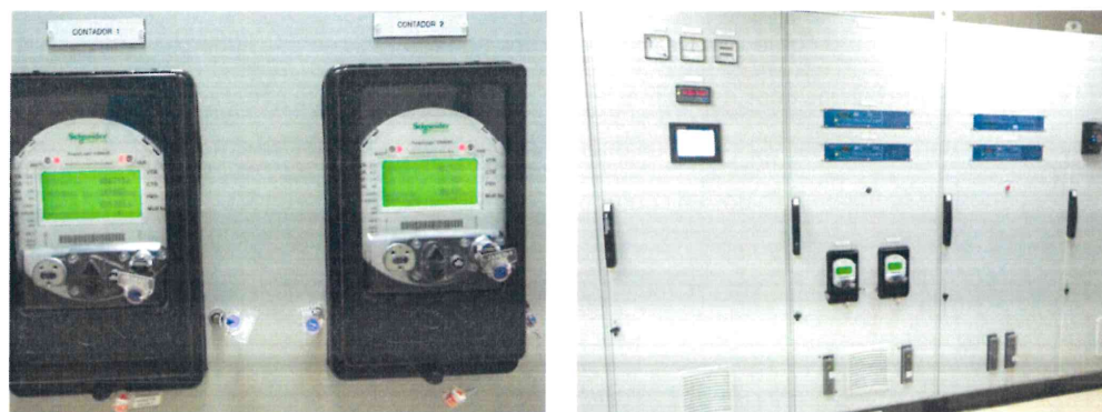
Imagen 31 Equipos de medición comercial instalados por el CND
