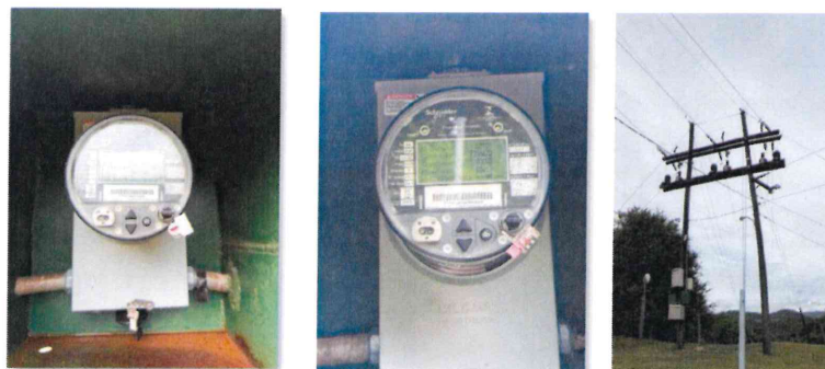
Imagen 40 Punto de medición y conexión a la red de 34.5 kV en el circuito L332 (fuente: propia)
