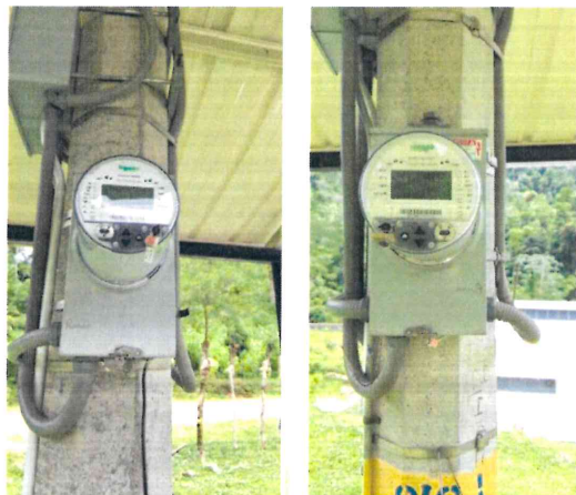
Imagen 18 Equipos de medición comercial instalados por el CND donde se registra consumo de energía
