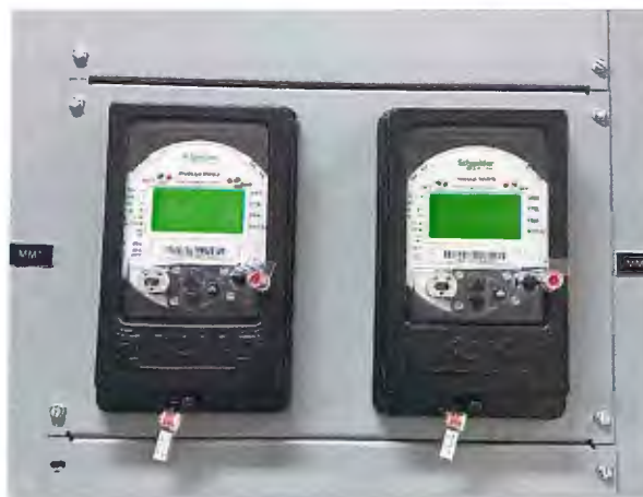
Imagen 31 Equipos de medición comercial instalados por el CND
