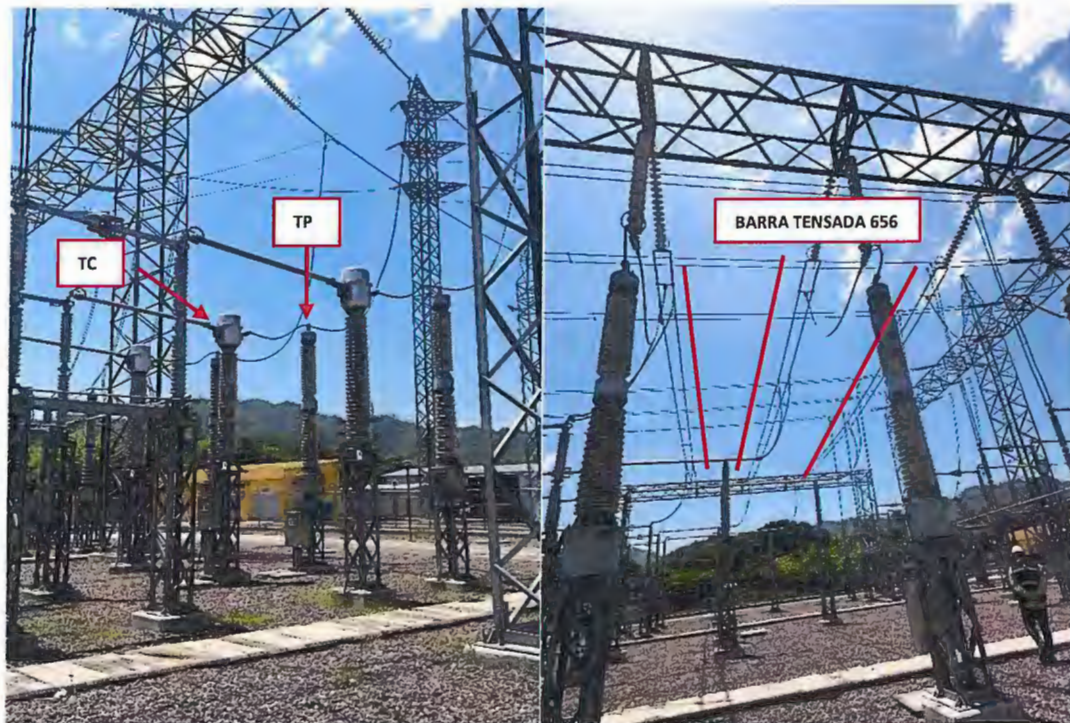
Imagen 23 a la izquierda, transformadores de corriente y potencial; a la derecha, barra tensada 656
