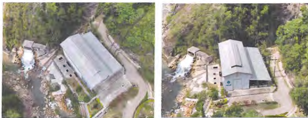
Imagen 47 Ubicación de la central generadora
