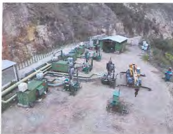
Imagen 41 Vista general con pozos de extracción de vapor a la izquierda y sistema de enfriamiento a la derecha.
