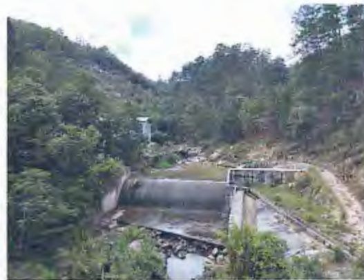
Imagen 37 a la izquierda, emplazamiento de la casa de máquinas; a la derecha, estructura de captación del recurso hídrico.
