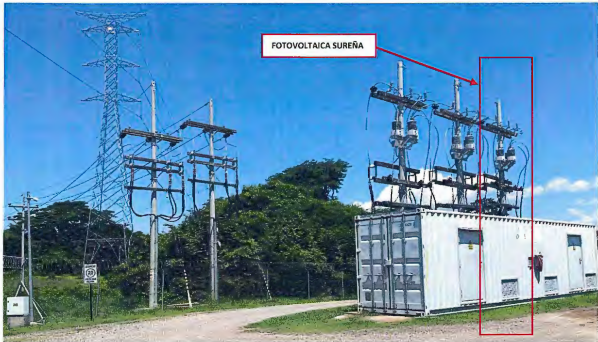
Imagen 15 Líneas en doble terna que se dirigen a la subestación Los Prados
