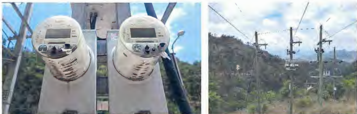
Imagen 39 a la izquierda equipo de medición principal y de respaldo, Derecha punto de conexión
