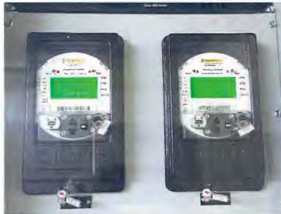
Imagen 25 Equipos de medición comercial instalados por el CND donde se registra consumo de los tres proyectos
