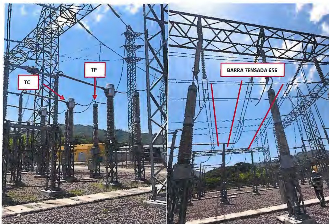
Imagen 16 a la izquierda se observa el punto de Conexión y Medición y derecha los Transformadores de corriente y potencial de la Barra tensada 656
