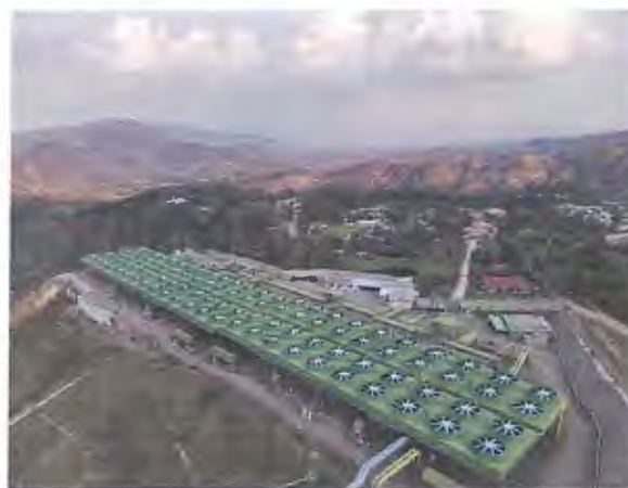
Imagen 41 Vista general con pozos de extracción de vapor a la izquierda y sistema de enfriamiento a la derecha.
