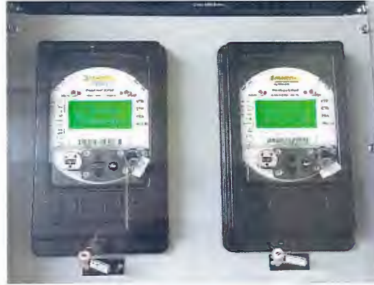
Imagen 18 Equipos de medición comercial instalados por el CND donde se registra consumo de los tres proyectos
