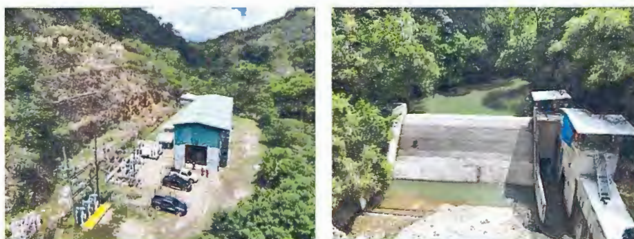
Imagen 33 a la izquierda, vista de la casa de máquinas; a la derecha, estructura de captación.
