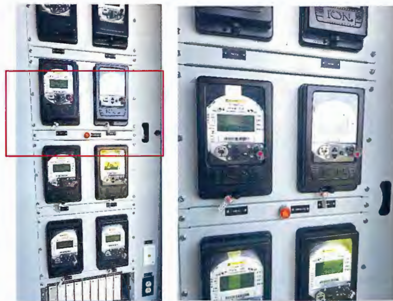
Imagen 12 Equipos de medición comercial instalados por el CND donde se registra de manera independiente la medición de Energías Solares
