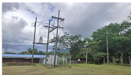
Imagen 18 A la izquierda equipos de medición y a la derecha punto de conexión
