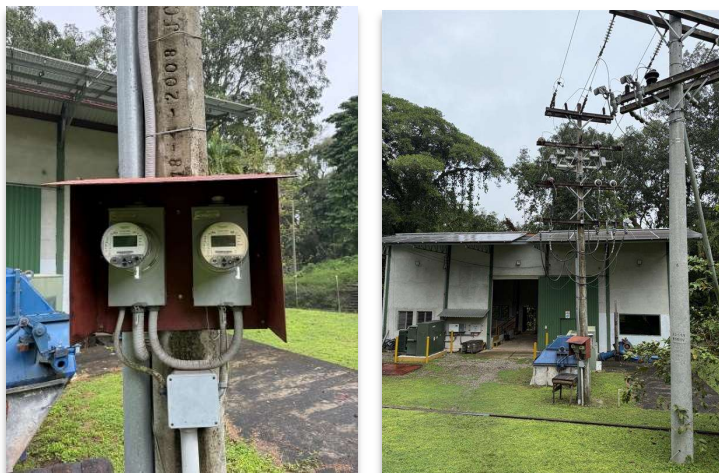
Imagen 31 Punto de medición central Peña Blanca (fuente: propia)
