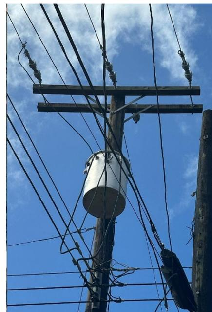
Se realizó el levantamiento del 100% de la red de distribución misma que cuenta con 469 postes, la red se encontraba en mal estado, con bastante margen de mejora tanto de las estructuras que tenían postes de madera rústica no curada, también a las estructuras primarias y secundarias, y a los transformadores.
