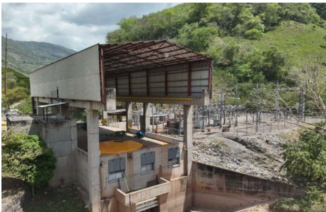
Imagen 6 Verificación de puntos de interconexión y estructura de obra civil El Nispero
