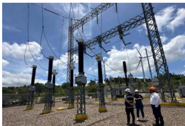
Imagen 2 Verificación de puntos de interconexión central eólica Planta San Marcos
